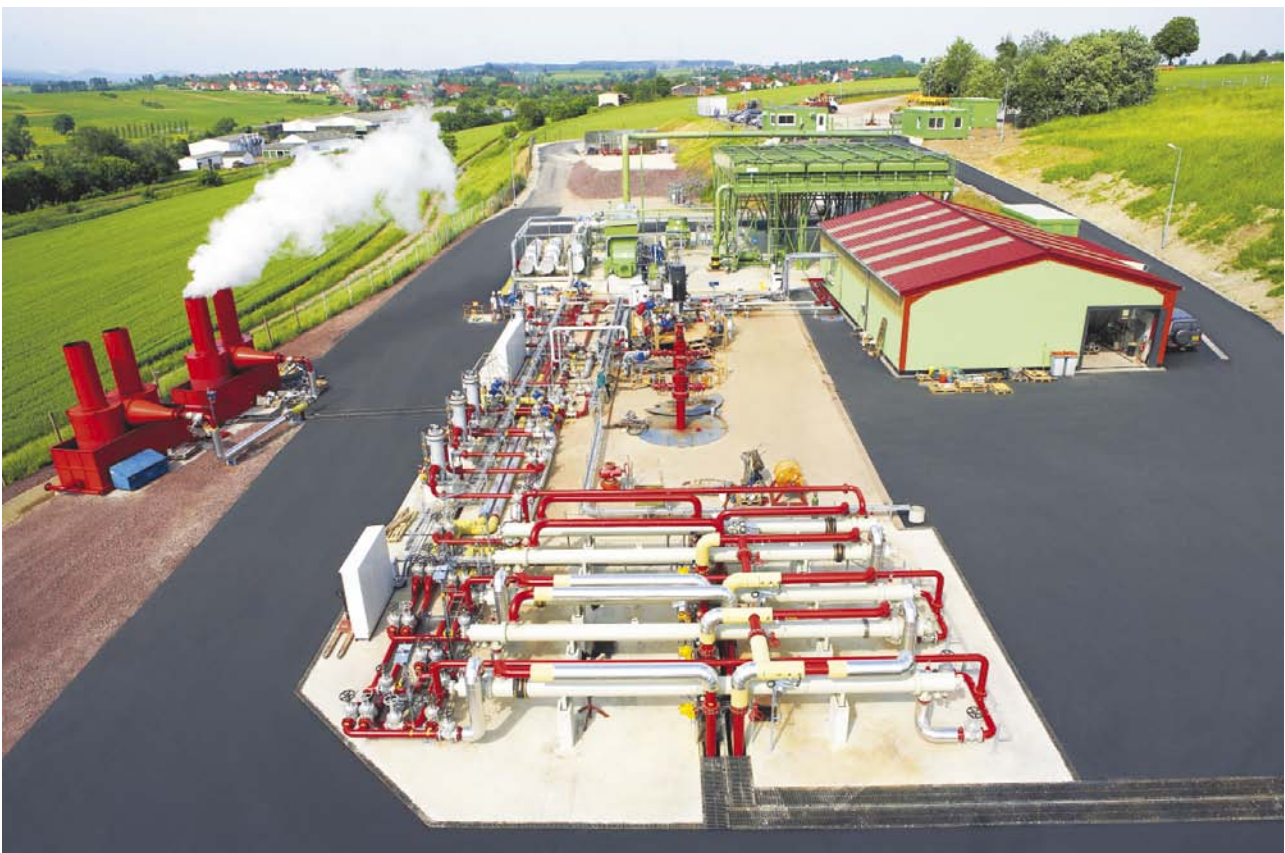
Abb. 17: HDR-Anlage Soultz-sous-Forêts (Quelle: Groupement Européen d'Intérêt Économique (GEIE) „Exploitation Minière de la Chaleur“)
