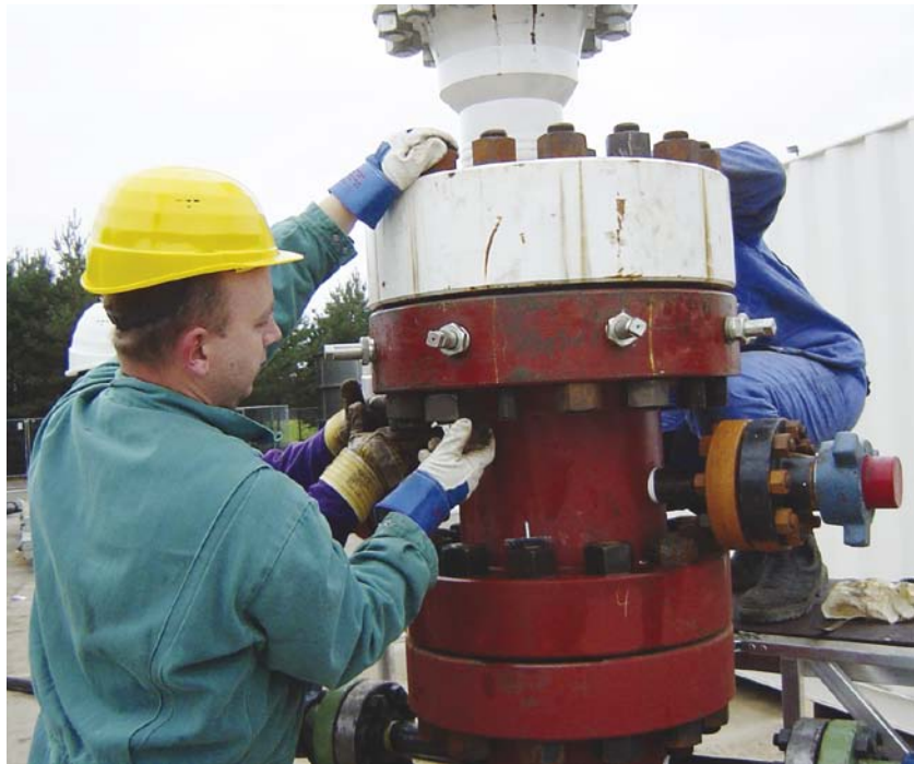
Abb. 9: Arbeiten am Bohrlochkopf
