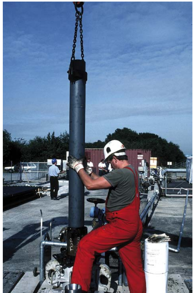
Abb. 40: Einbau der Pumpe in die Tiefbohrung GB2
