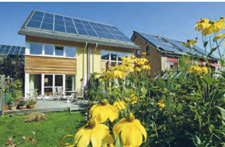
Kollektoranlage zur Warmwasserbereitung
