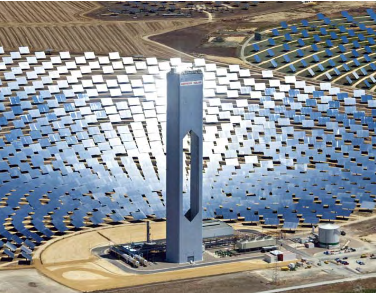
Das weltgrößte Solarturmkraftwerk steht in Spanien und produziert 20 Megawatt elektrische Leistung. 1.255 Spiegel reflektieren die Sonnenstrahlung auf den Receiver des 160 m hohen Solarturms.
