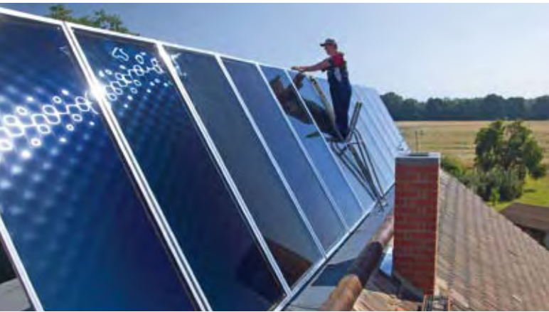
Montage einer Kollektoranlage zur Warmwasserbereitung
