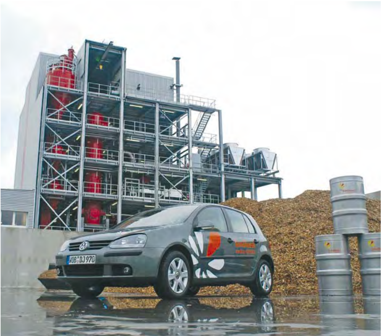
Diese Anlage vergast Biomasse und produziert daraus einen synthetischen Biokraftstoff.
