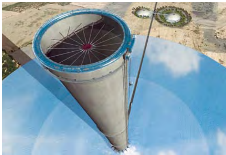
Turm des geplanten 200-MW-Aufwindkraftwerks (Höhe 1.000 m, mit speziellen Speichenrädern zur Stütze), unten das Kollektordach (Durchmesser 6 km)
