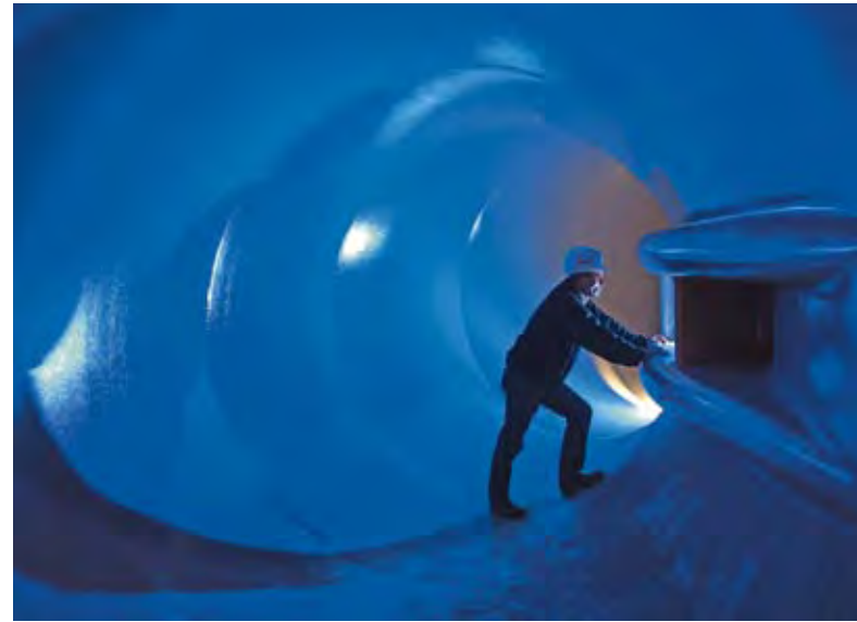
Prüfung einer im Bau befindlichen Turbinenanlage. Durch dieses Schneckenrohr drückt das Wasser später auf die Turbinenschaufeln.
