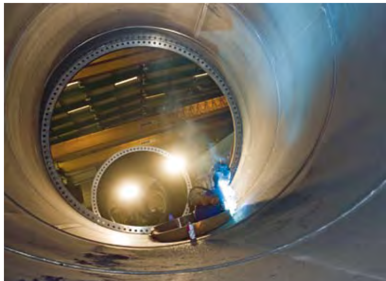
Stahlturnfertigung für Windkraftanlagen
