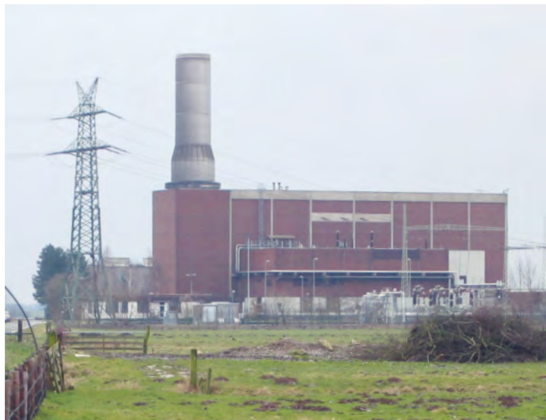
Seit dreißig Jahren erzeugt dieses Druckluft-Speicherkraftwerk in Huntorf Strom.
