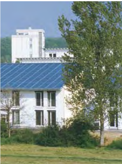
Flachkollektoren, transparente Wärmedämmung und Vakuumröhrenkollektoren
