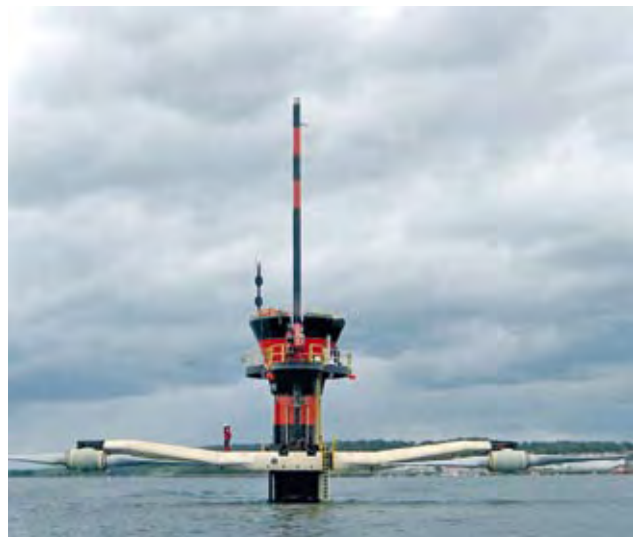
Strömungskraftwerk „SeaGen“ an der schottischen Küste
