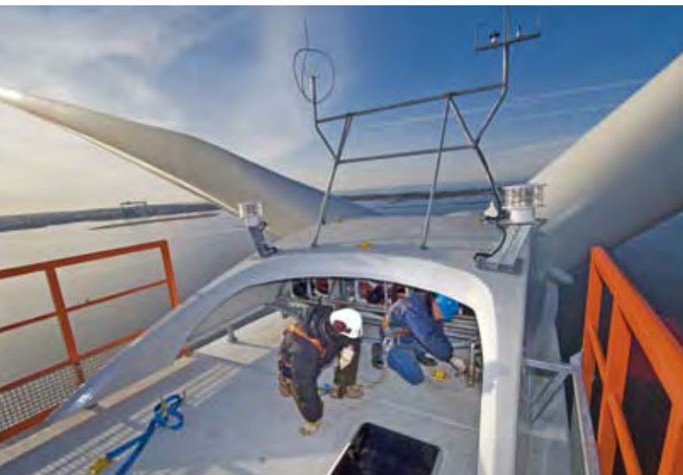
Montagearbeiten auf der Gondel einer 2,5-MW-Anlage
