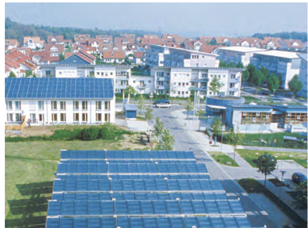
In Neckarsulm werden die Parkplatzflächen zur Wärmeerzeugung genutzt.
