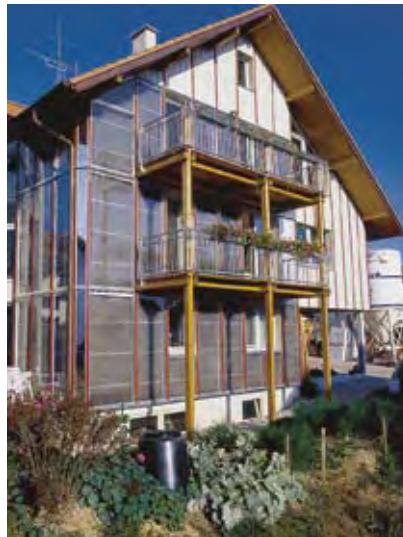
Flachkollektoren, transparente Wärmedämmung und Vakuumröhrenkollektoren
