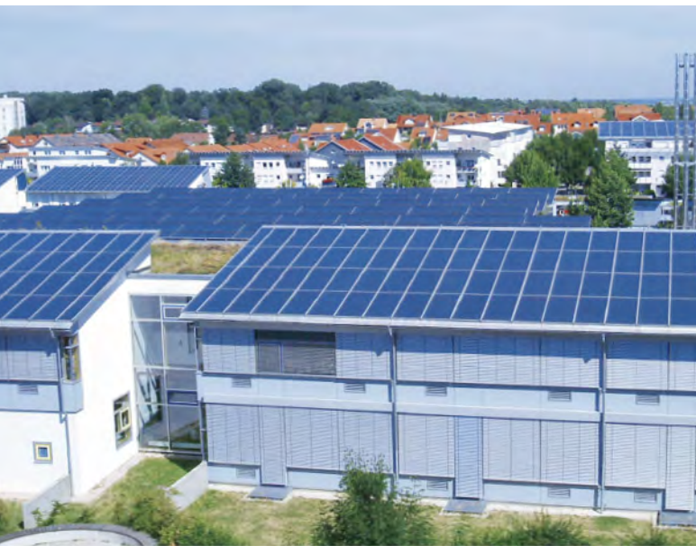
In Neckarsulm versorgt ein großes Sonnenkollektorfeld ein Nahwärmenetz.
