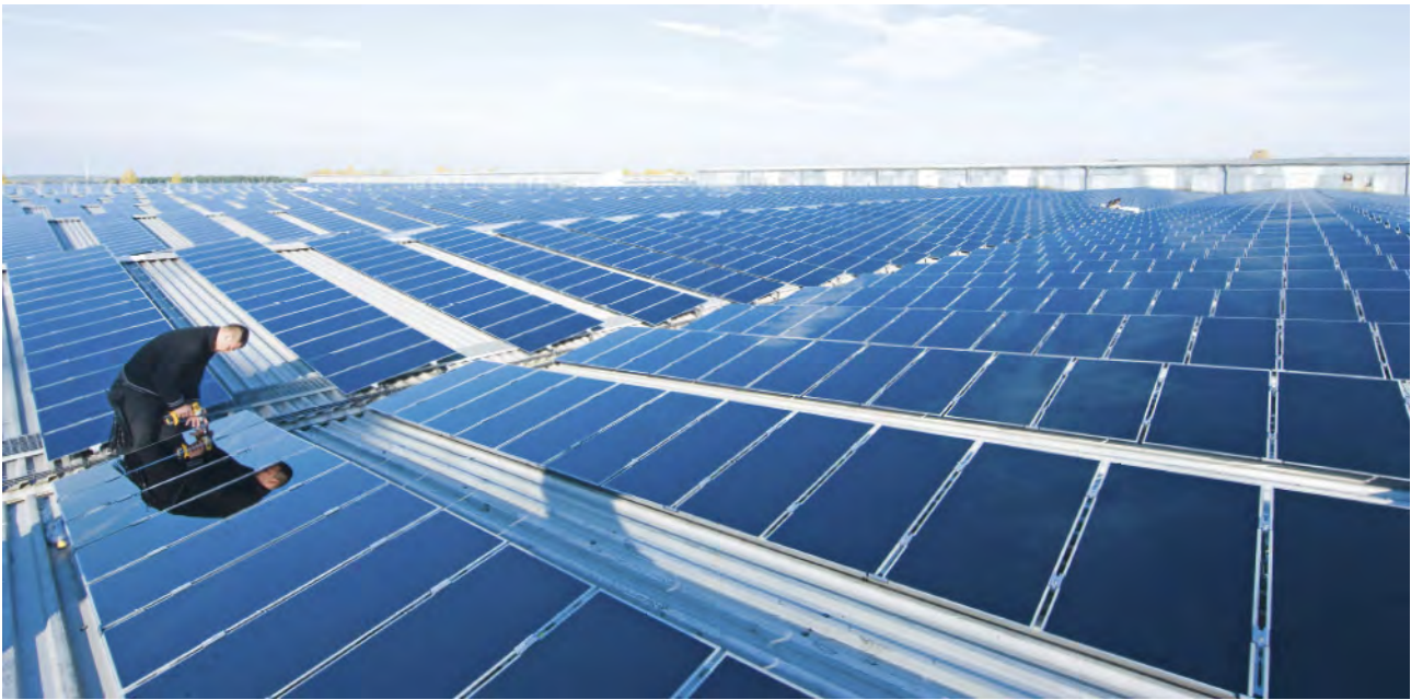
Montage einer Solarstromanlage mit einer Leistung von 4,6 MW
