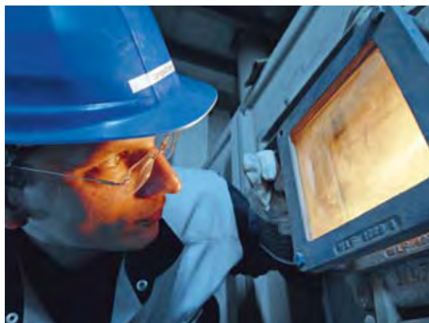
Sichtprüfung des Brennvorgangs in einem Biomasse-Heizkraftwerk
