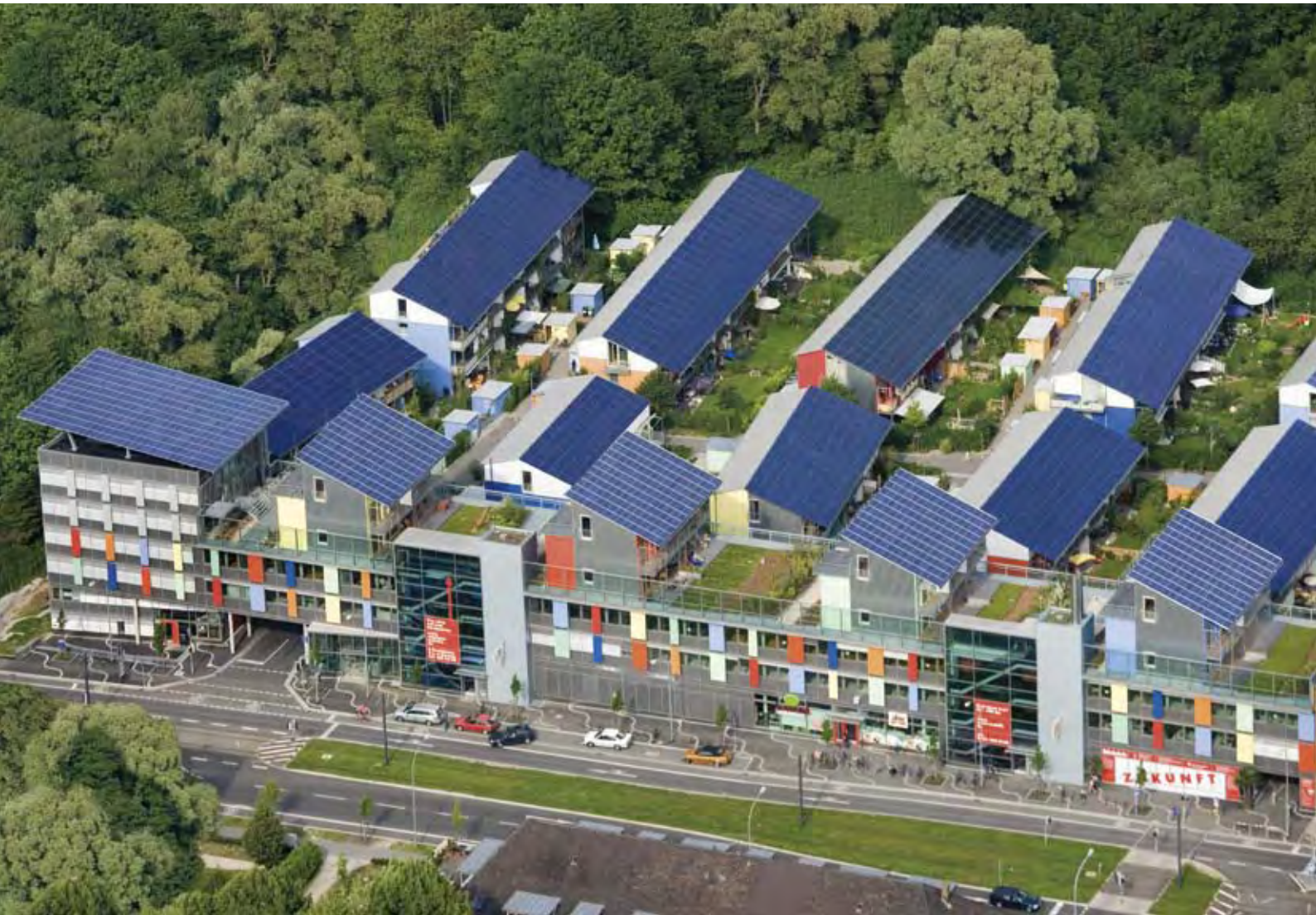
Netto-Plusenergiehäuser sind so konstruiert, dass sie im Jahresverlauf mehr Energie produzieren als verbrauchen.
