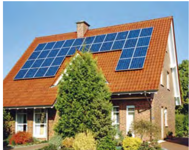
Netzgekoppelte Anlagen speisen den überschüssigen Strom in das Stromnetz ein, wobei diese Einspeisung zu festen Tarifen vergütet wird.
