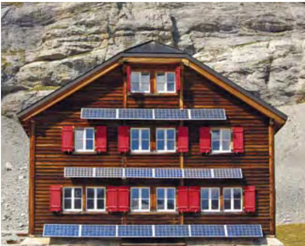
Netzunabhängige PV-Anlagen produzieren Solarstrom ausschließlich für den Eigenverbrauch.
