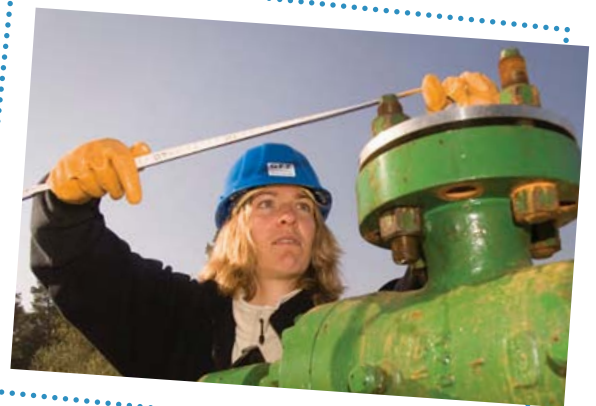
Technikerin überprüft Ventil (Geothermiebohrung)
