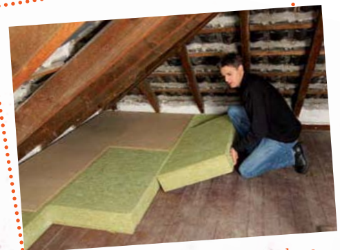
Wärmedämmung des Dachbodens
