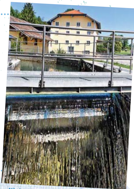
Kleines Wasserkraftwerk am Fluss
