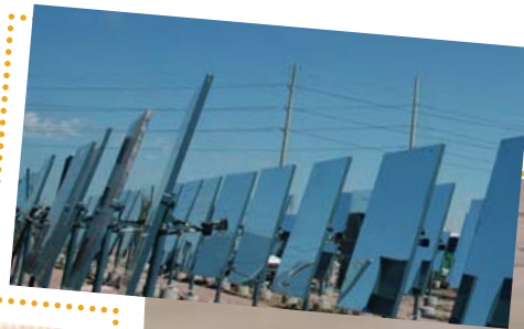
Spiegel des Solarturmkraftwerks
