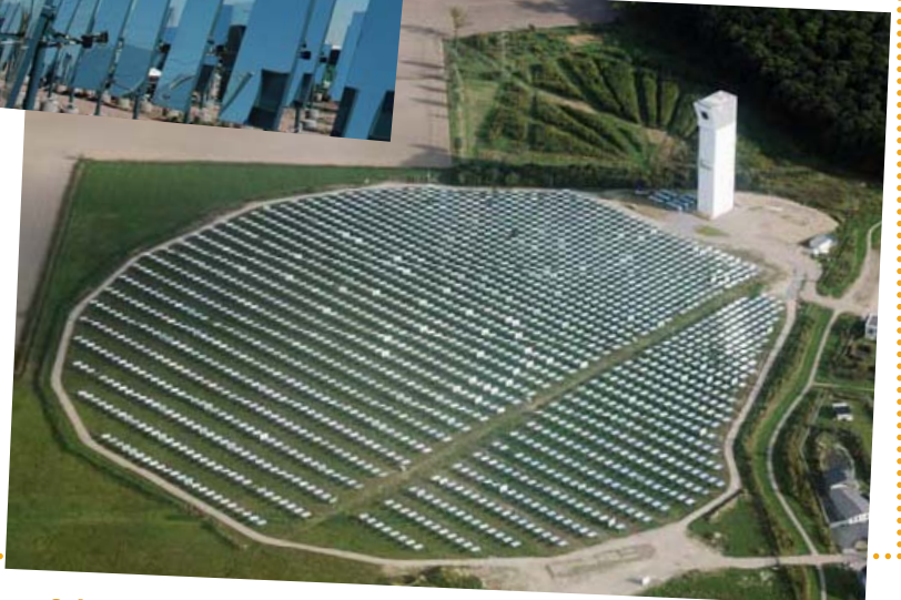
Solarturmkraftwerk zur Stromerzeugung in Jülich, Deutschland
