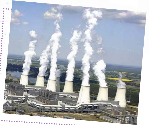
Kohlekraftwerk zur Erzeugung von Strom
