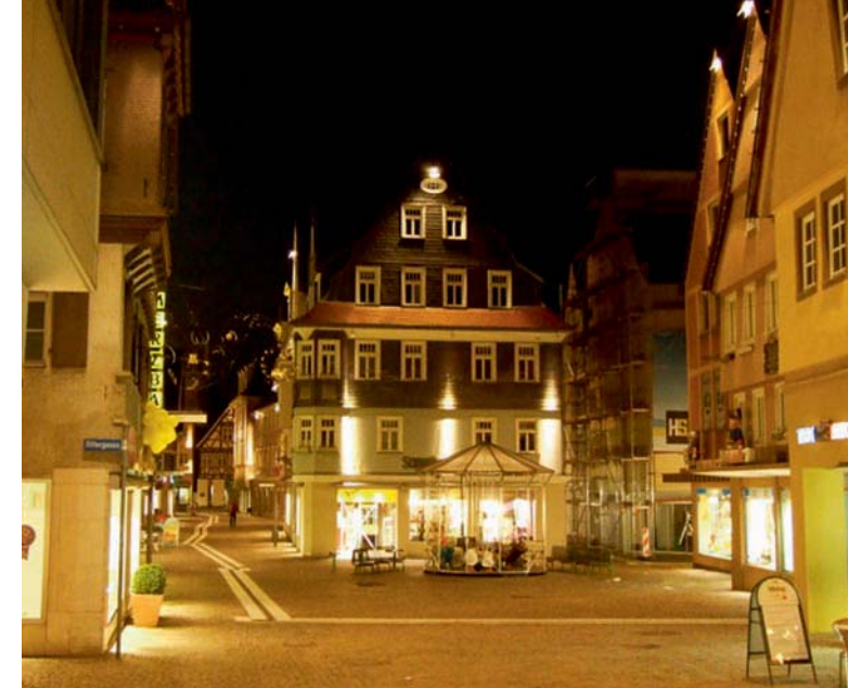
Neue Flächenstrahler (Quelle: Tiefbauamt Aalen)
