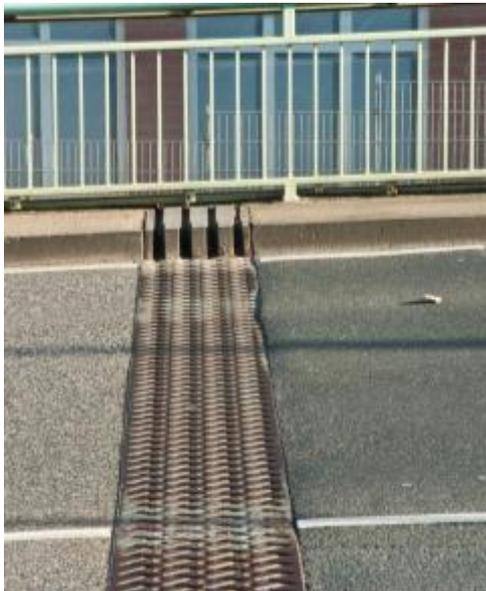
Dehnungsfugen /Verzahnungsfuge an einer Brücke
