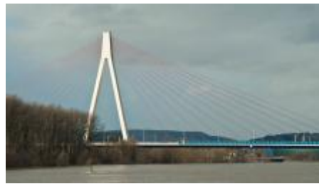
Geländer an einer Schrägseilbrücke Foto: PL Koblenz
